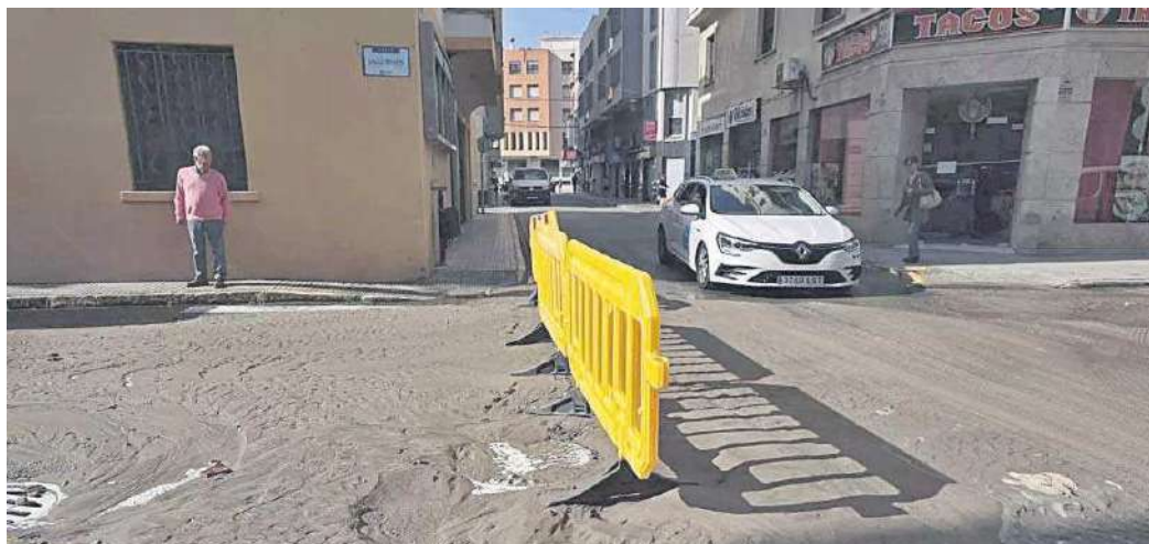
El centro de La Línea tras reventar una tubería en la calle Clavel.
