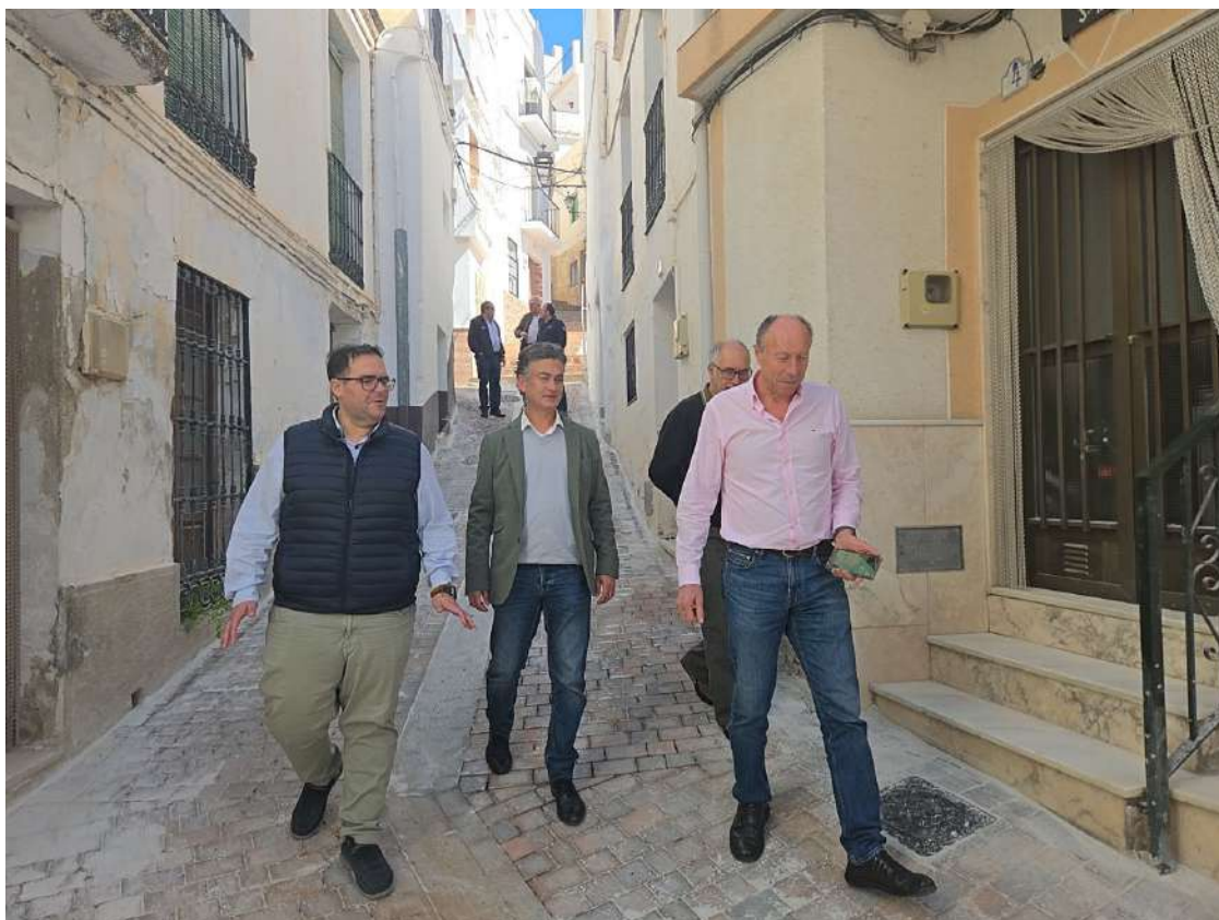
Visita a las obras de la calle Estación de Otívar (EL FARO)
