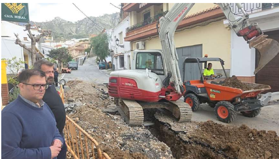
Visita a la obra de Lentegí / G.H.
