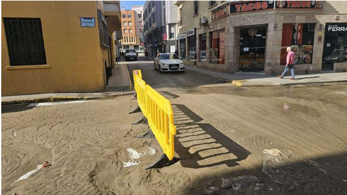
Revienta una tubería en pleno centro de La Línea y deja un lodazal tras anegar la calle Clavel.
