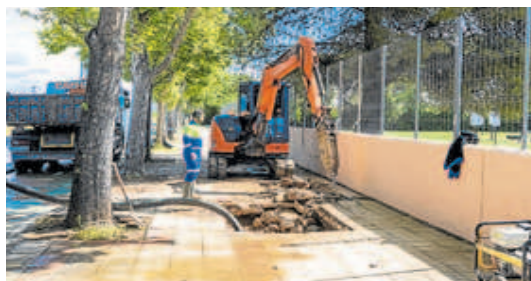
Operarios de Aqualia en la zona de la avería. ÁNGEL MÁRQUEZ
